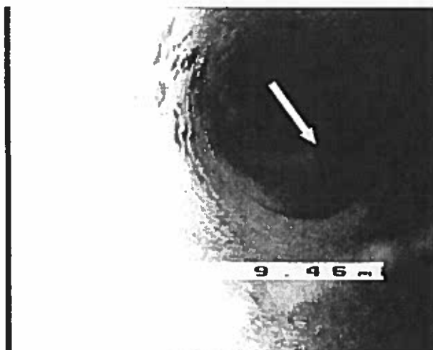
FOTO 003: 7.7m - netěsnost, rozsazený spoj, exfiltrace
